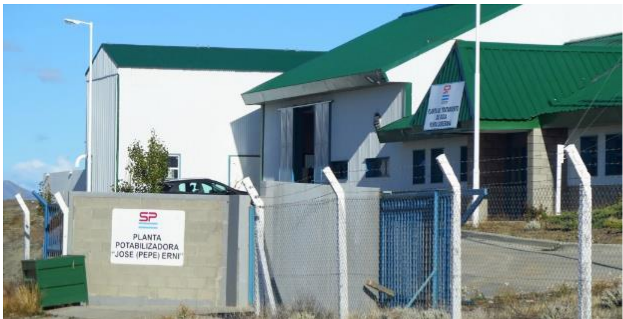
Figura 17-75. Planta potabilizadora de agua de SP, El Calafate.
