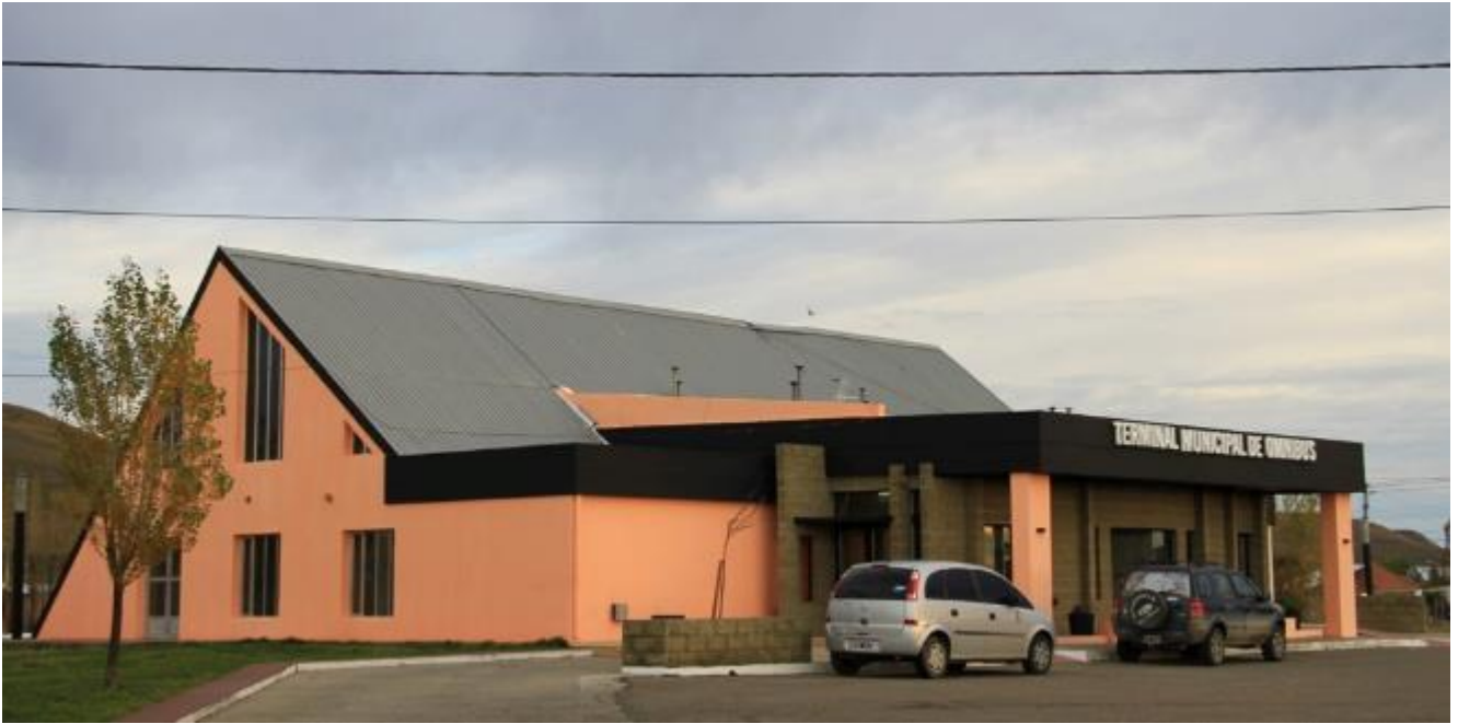
Figura 17-218. Terminal de Ómnibus, Puerto Santa Cruz.
