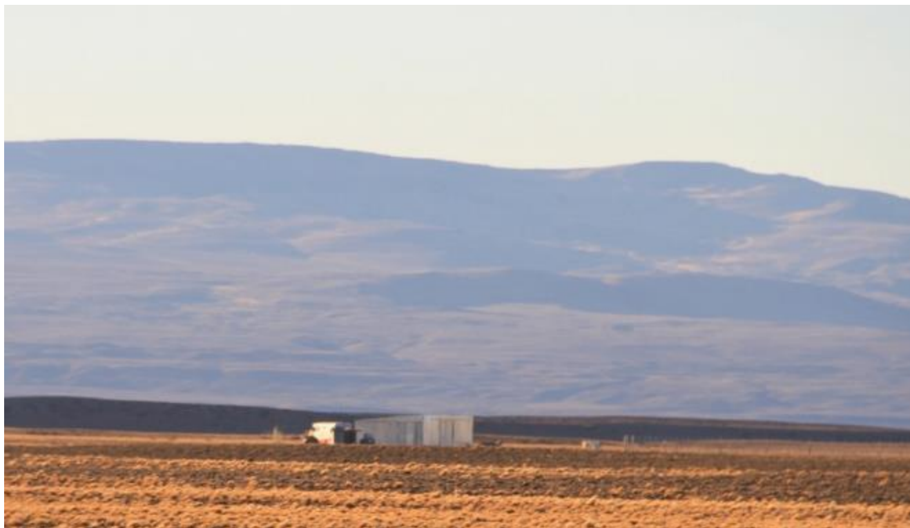
Figura 17-360. Infraestructura productiva, Ea. Río Bote.
