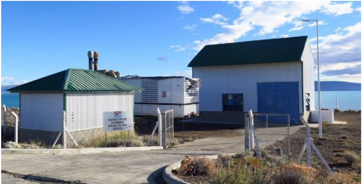
Figura 17-74. Estación de bombeo de agua de SP, El Calafate.
