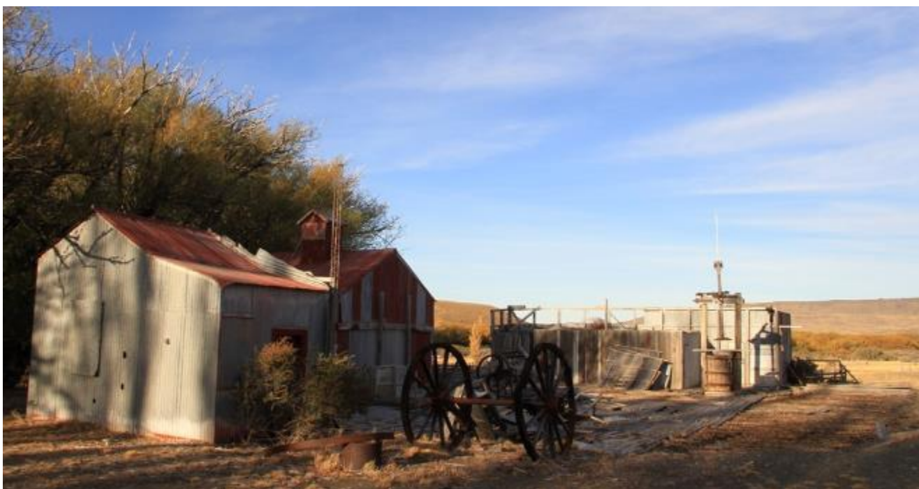
Figura 17-295. Infraestructura y servicios, Ea. Condor Cliff
