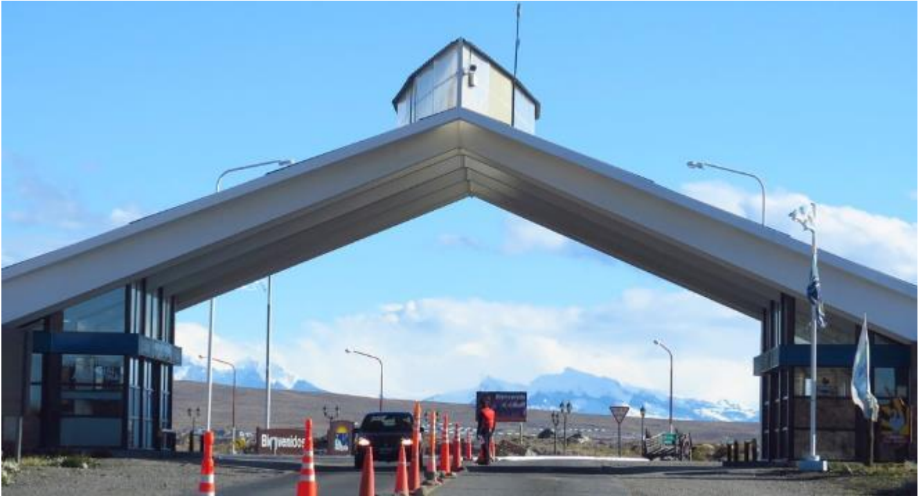
Figura 17-86. Puesto de Gendarmería y de la Policía Provincial en acceso a El Calafate, Ruta Nº 11.
