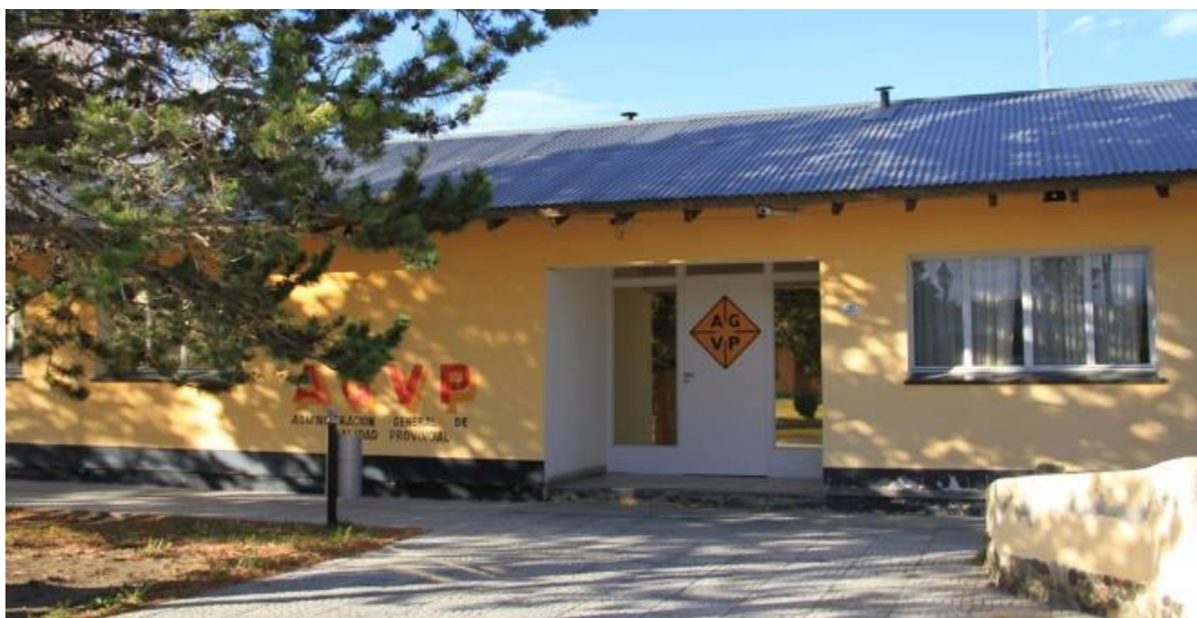
Figura 17-167. Administración General de Vialidad Provincial, Cmdte. Luis Piedrabuena.
