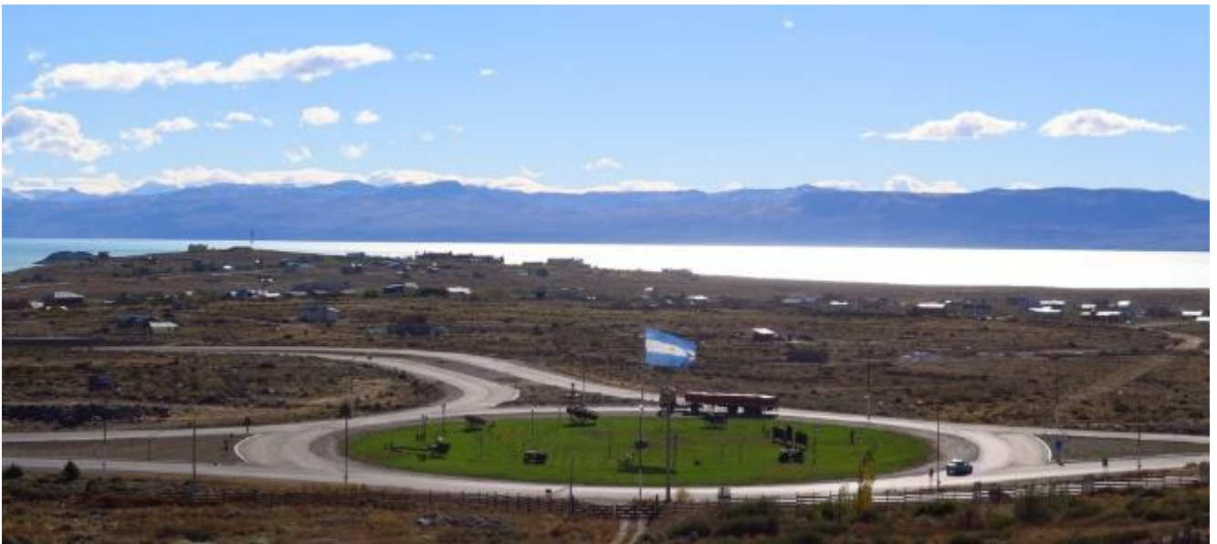
Figura 17-104. Rotonda de acceso a El Calafate, RP N° 11.
