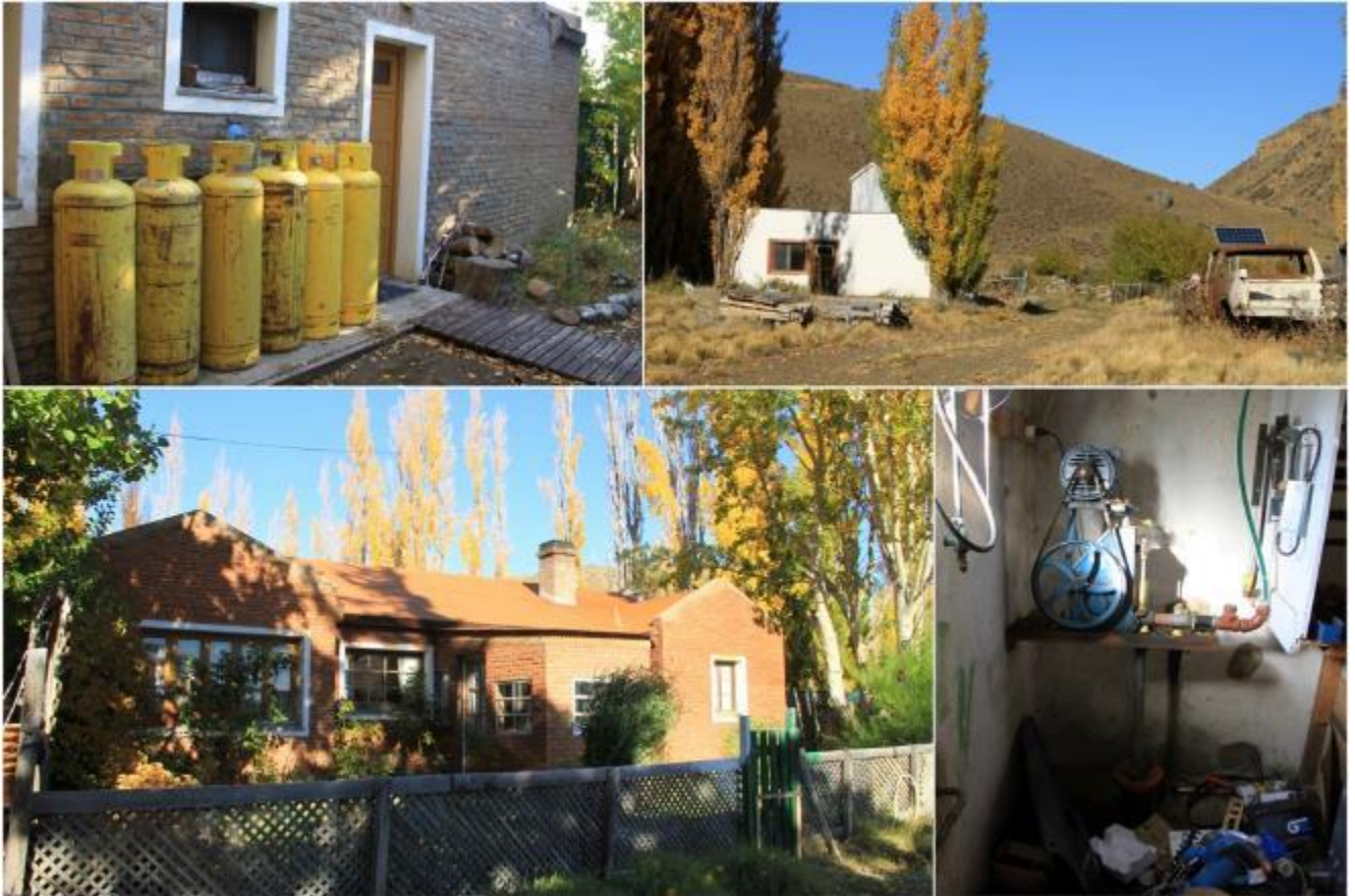
Figura 17-370. Infraestructura de vivienda y servicios, Ea. La Josefina.
