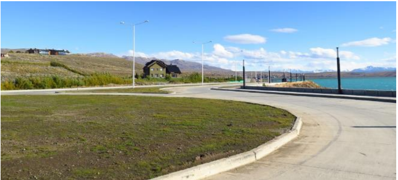
Figura 17-77. Expansión de la pavimentación de la Av. Costanera, El Calafate.
