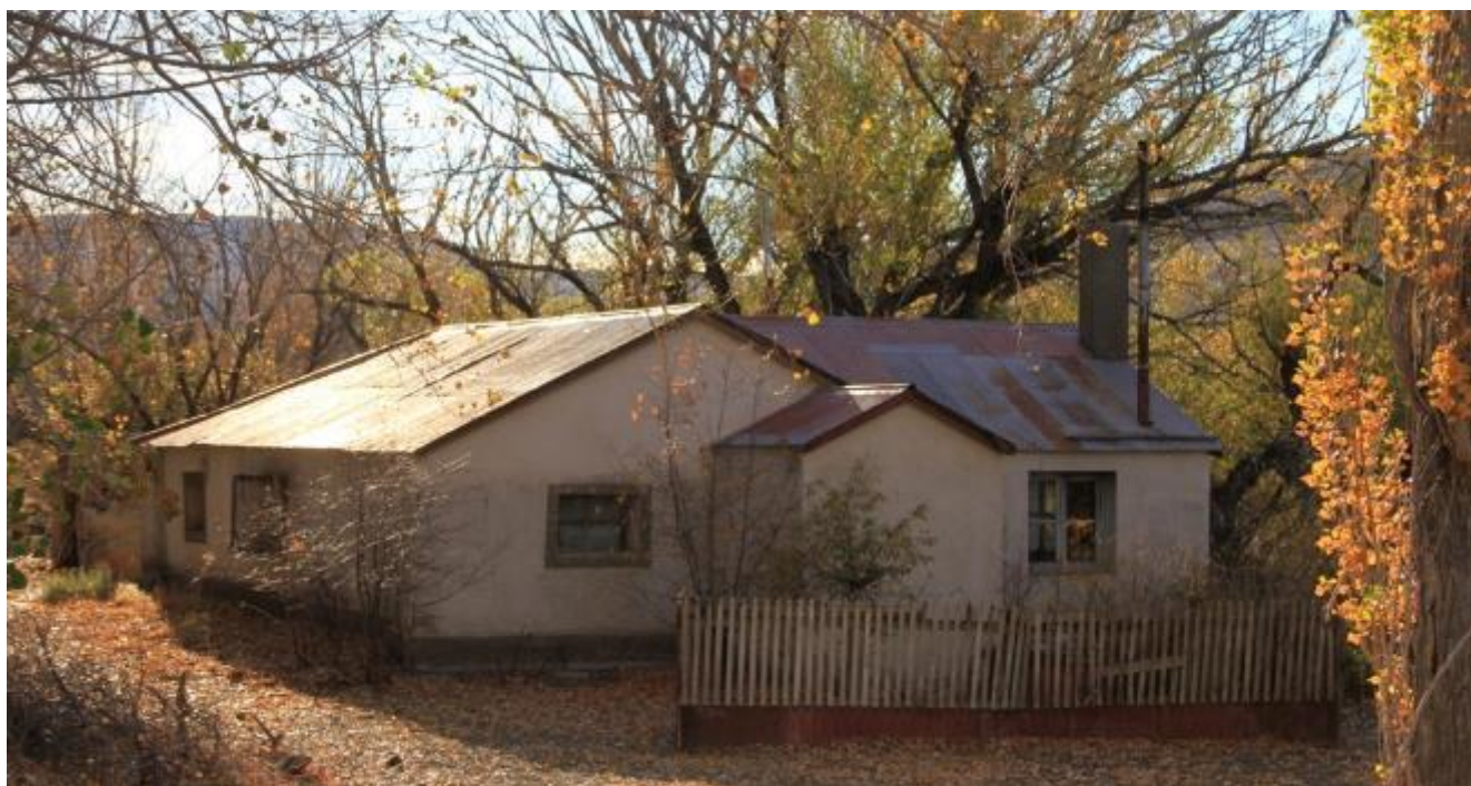
Figura 17-294. Vivienda, Ea. Condor Cliff.
