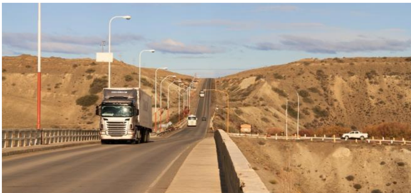
Figura 17-165. Tránsito sobre puente (RN3) sobre el Río Santa Cruz, Cmdte. Luis Piedrabuena.
