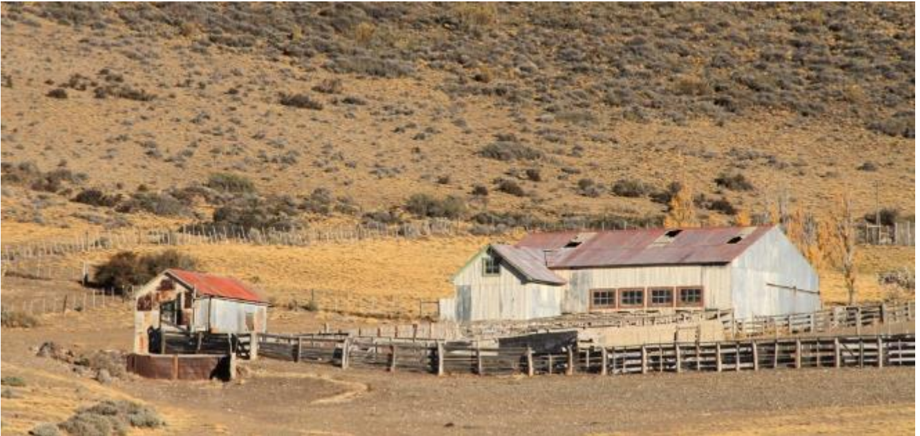
Figura 17-344. Galpones y corrales en desuso, Ea. Rosita.
