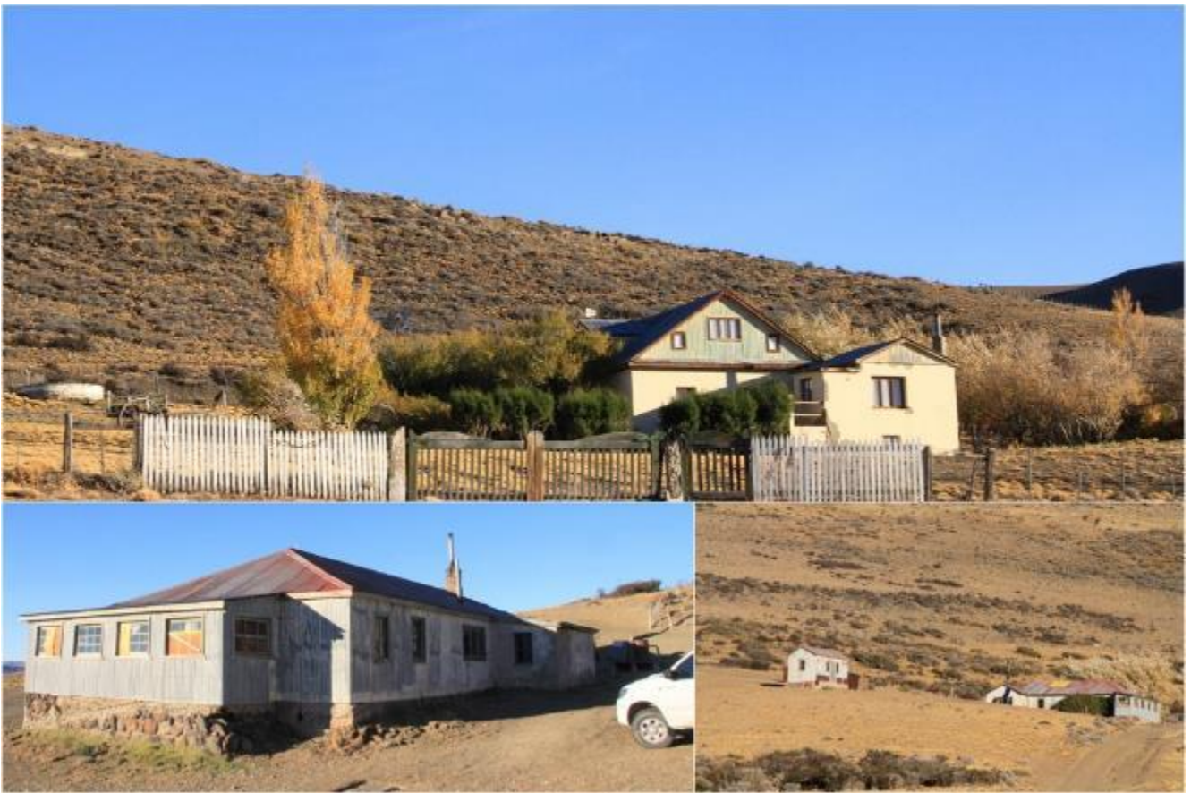
Figura 17-343. Infraestructura de vivienda, Ea. Rosita.
