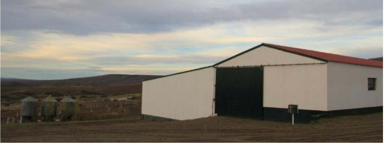
Figura 17-318. Galpón y Silos, Ea. San Ramón.
