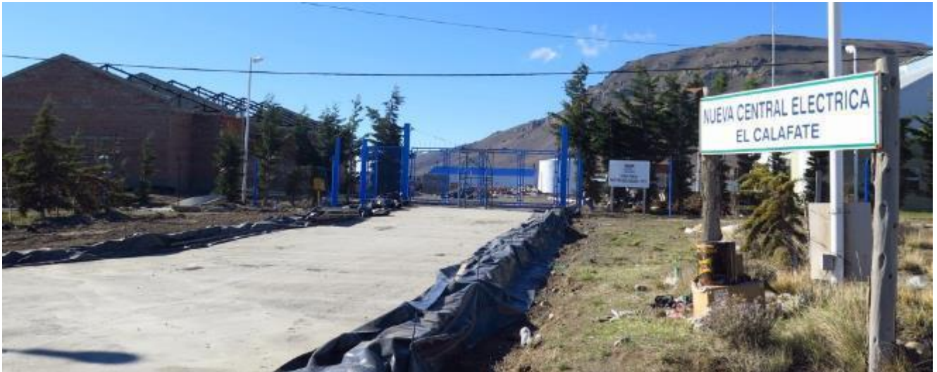
Figura 17-73. Central eléctrica El Calafate.
