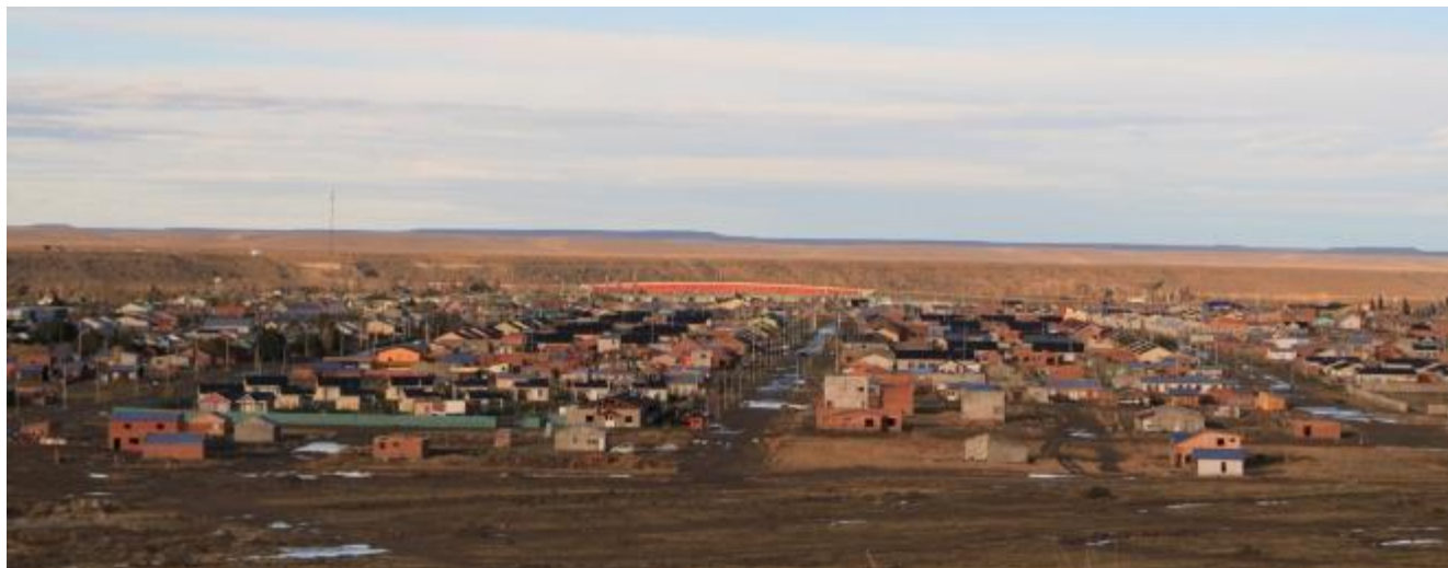
Figura 17-144. Expansión de redes de servicios y viviendas, Cmdte. Luis Piedrabuena.
