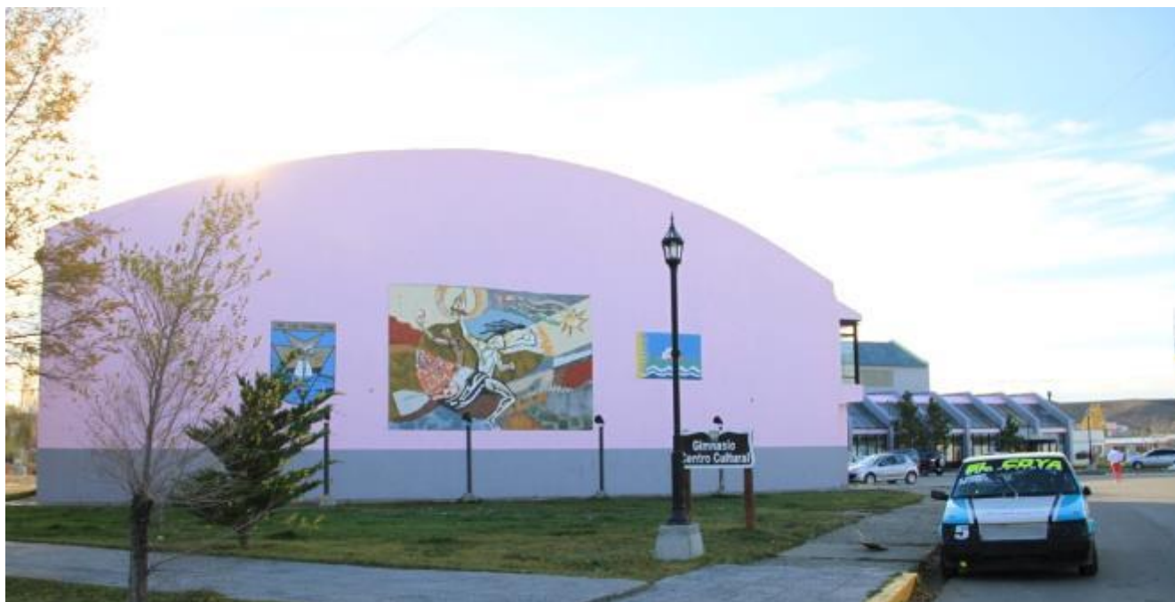
Figura 17-153. Gimnasio y centro Cultural Municipal, Cmdte. Luis Piedrabuena.
